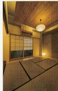
打ち放しの天井の約40cm下に木板の吊天井を設置し、コンクリートの打ち放しの壁と木材を違和感なく仕上げる事が出来ました
