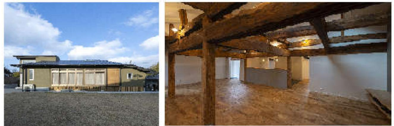
外壁はモルタル塗り、聚楽塗装で仕上げました、梁を研磨し床のフローリングと違和感なく仕上げることができました。
