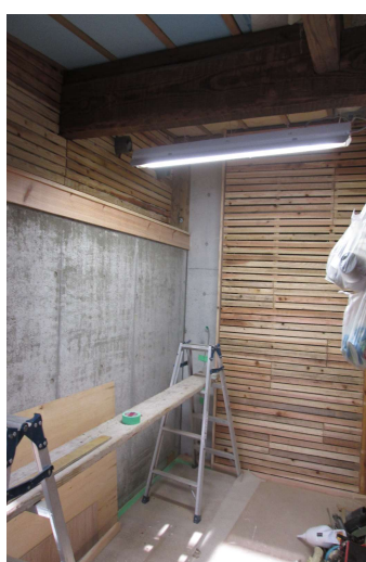
木摺漆喰工法（木摺下地） 砂漆喰施工状況
